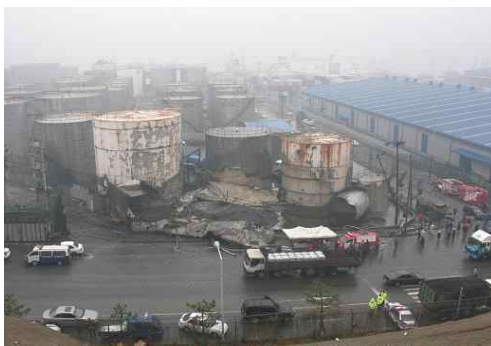
폭발한 축산폐수 저장탱크 현장
